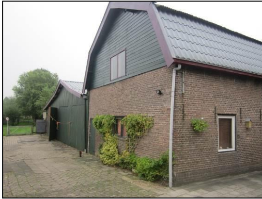
Schuur waarvan het noordelijke deel (achter) gesloopt wordt.
