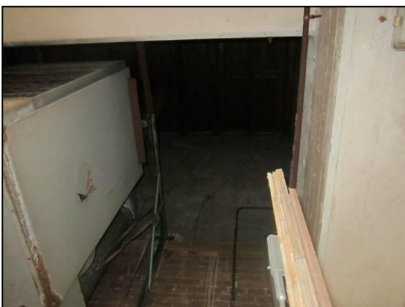
Kleine ruimte in loods met toegang tot 'zolder'.
