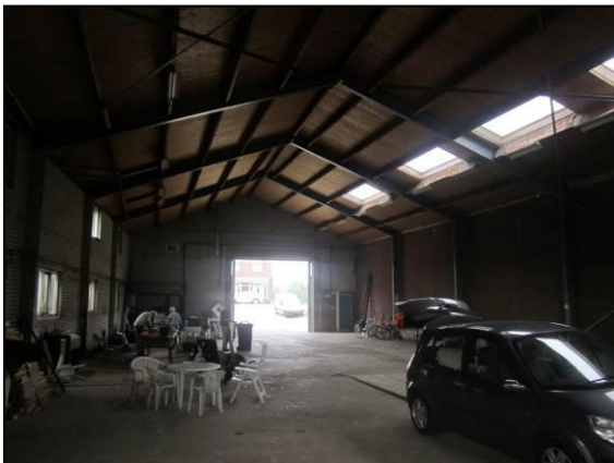
Binnenzijde loods ten westen van de kerk.
